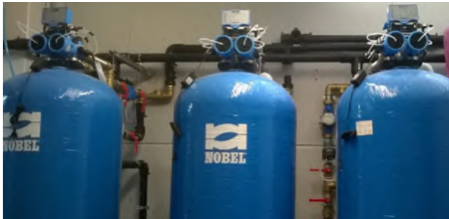
↳ Impianto osmosi inversa Generatore di vapore ↳
