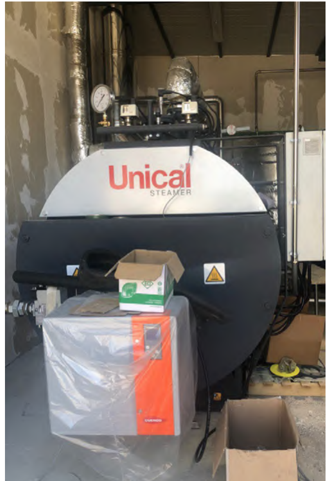
↳ Impianto osmosi inversa Generatore di vapore ↳
